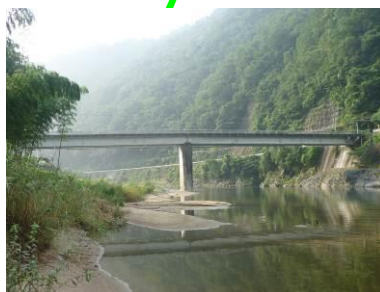
向光石橋 L=93.5m(PC橋) 1980年架設
