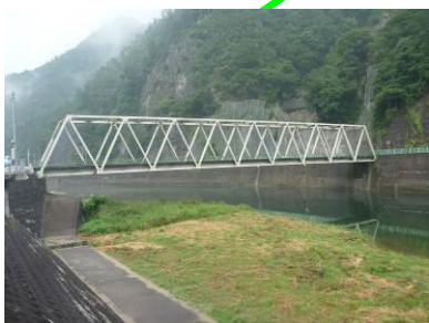
砂ヶ瀬橋 L=77.6m(鋼橋)
