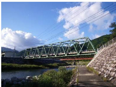
戸河内橋 L=57.0m(鋼橋)
