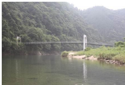
上殿橋 L=74.9m(木橋) 1949年架設
