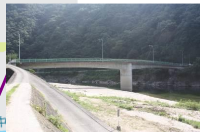
安野橋 L=106.5m(PC橋)
