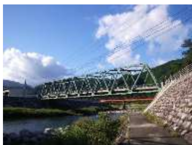
戸河内橋 L=57.0m(鋼橋) 2003年架設
