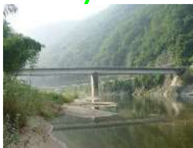
向光石橋 L=93.5m(PC橋) 1980年架設
