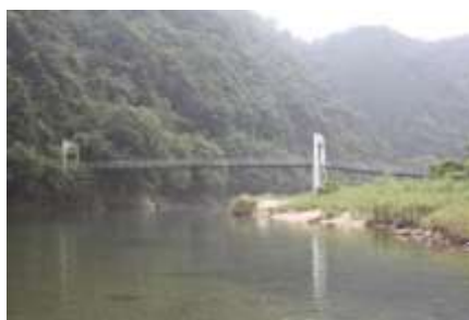
上殿橋 L=74.9m(木橋) 1949年架設
