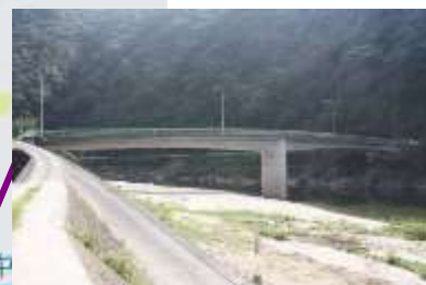
安野橋 L=106.5m(PC橋) 1989年架設
