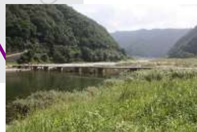
程原橋 L=130.0m(PC橋) 2000年架設
