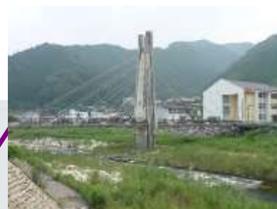
五輪橋 L=66.5m(PC橋) 1991年架設
