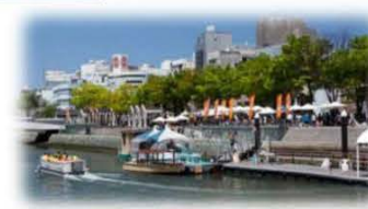
親水護岸の利用 (新町川/徳島市)
