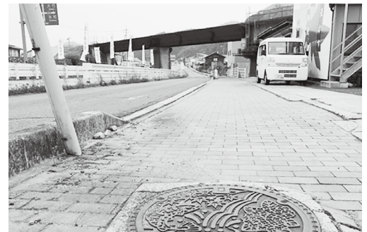
道の駅付近歩道マンホール
