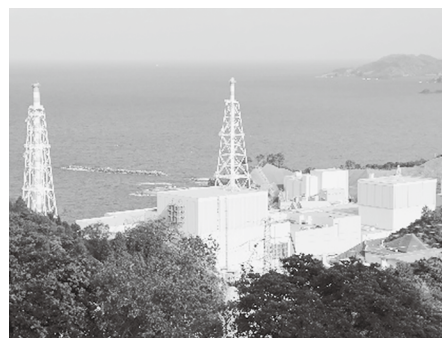
島根原子力発電所
