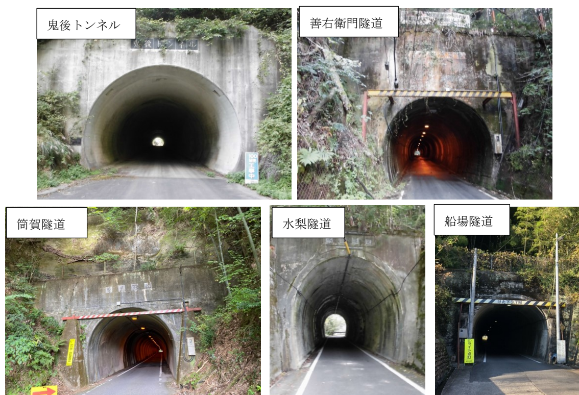
図 1-2 安芸太田町が管理するトンネル
