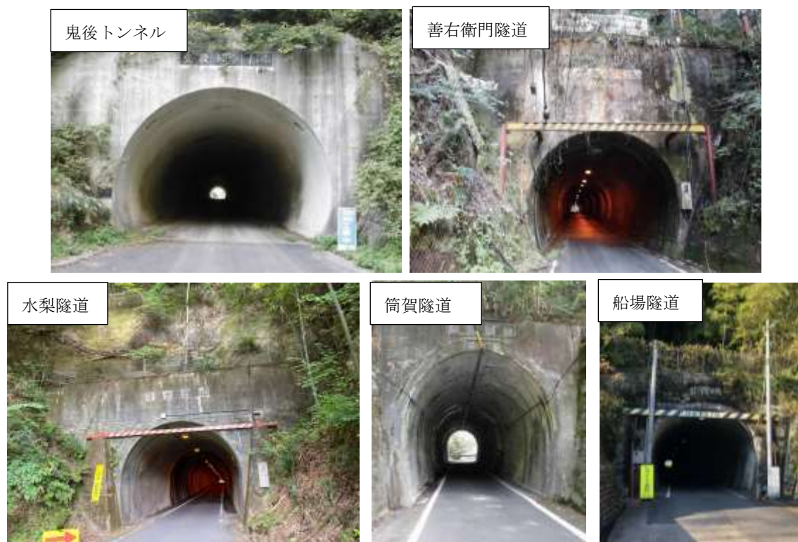
図 1-2 安芸太田町が管理するトンネル
