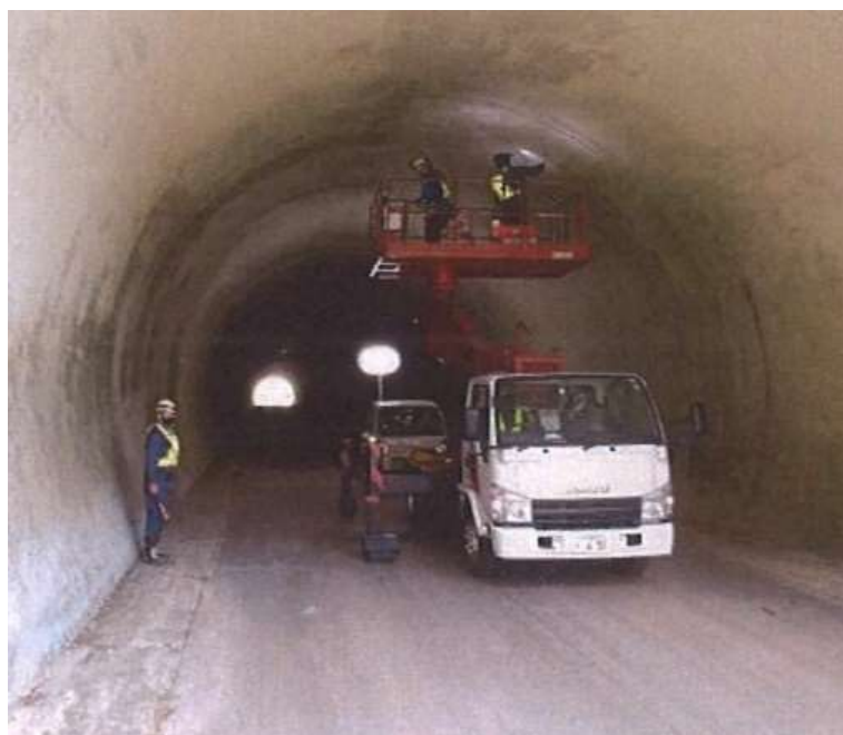
図 1-3 トンネル定期点検状況（令和 3 年度）
