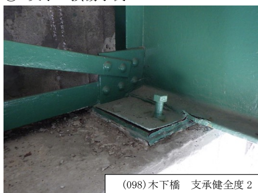
鋼製支承の腐食・ボルト緩み
