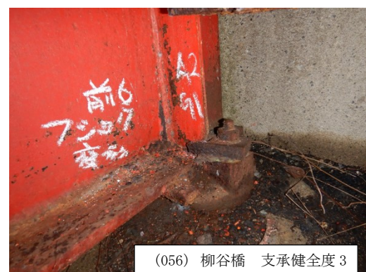
鋼製支承の腐食
