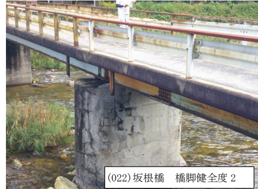
コンクリート下部工のひび割れ
