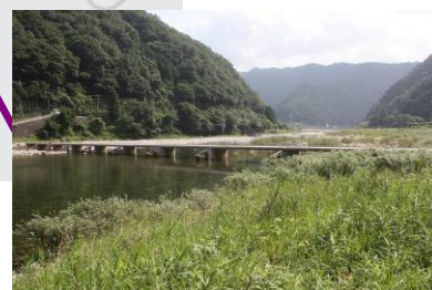
程原橋 L=130.0m(PC橋) 2000年架設
