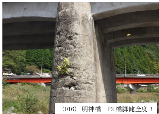
コンクリート下部工のひび割れ
