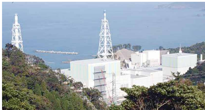
島根原子力発電所
