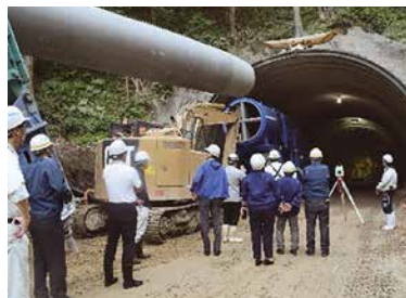
弁財天加計線 トンネル工事現場
