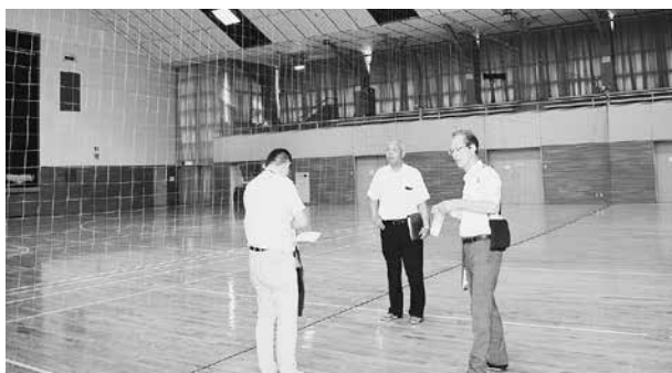
加計体育館の現状確認
