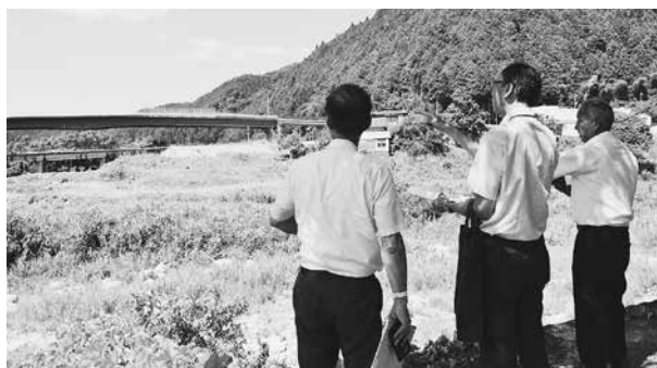
旧JR滝山川桥梁撤去状況を確認
