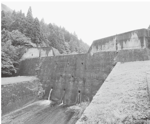
田吹川 砂防ダム
