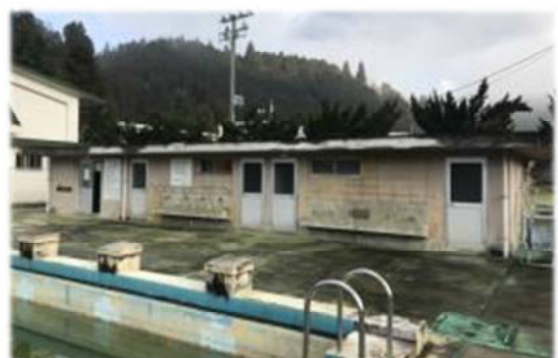
管理棟現況写真
