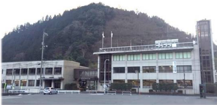
震災対策が急がれる役場本庁舎(本館・東館)
