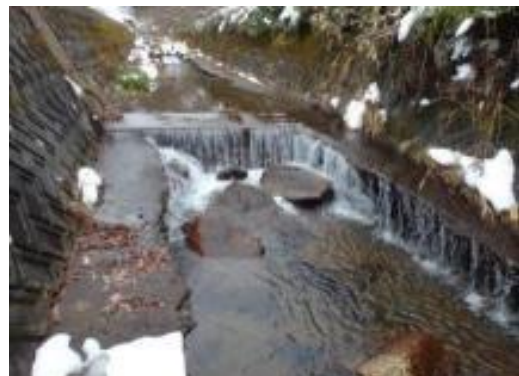
河川護岸損傷状況
