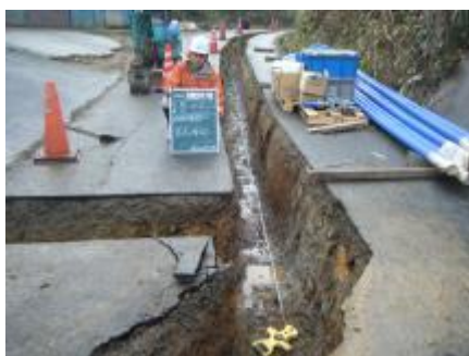
簡易水道 (管路更新)
