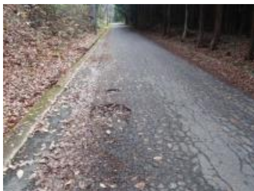
町道舗装損傷状況
