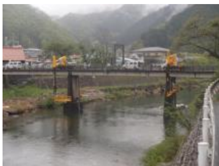
橋梁点検状況
