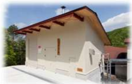
バイオマス(チップ)ボイラー事業 (いこいの村ひろしま)
