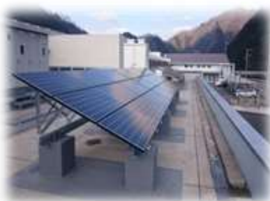
ソーラーパネル(安芸太田病院)
