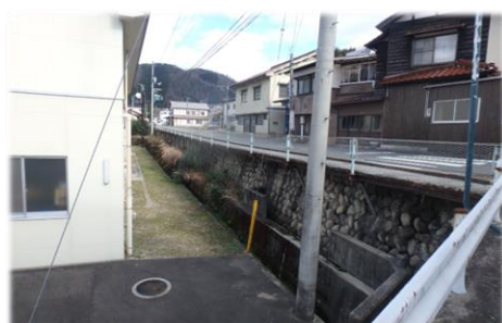
町道張出歩道の状況
