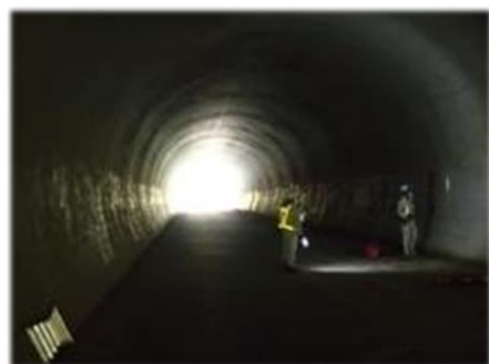
トンネル点検状況
