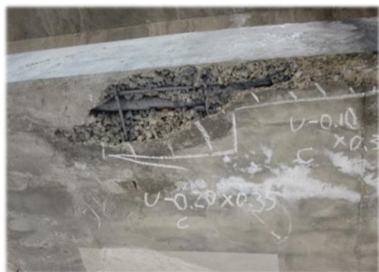
内部の鉄筋がむき出しの様子
