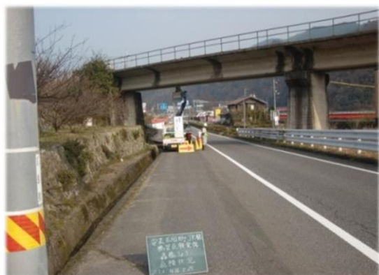
高所作業車による点検の様子
