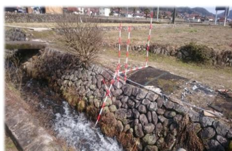
河川護岸の崩壊状況
