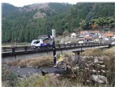
橋梁点検状況
