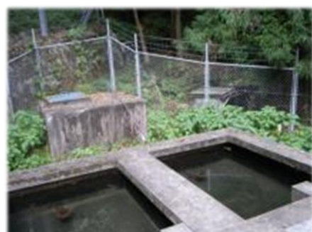
簡易水道施設
