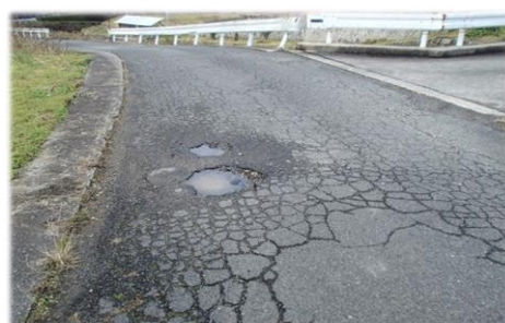
町道舗装損傷状況
