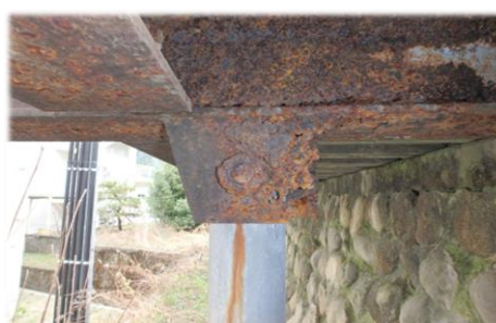
床版下の劣化状況
