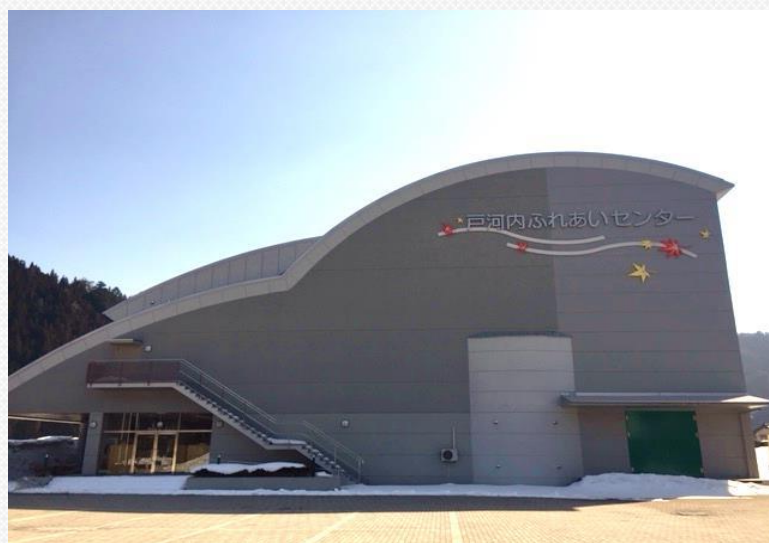
▲大規模改修を終え、リニューアルオープンした戸河内ふれあいセンター
