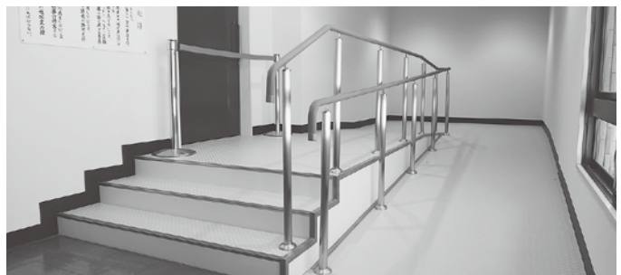
傍聴席入口のスロープ設置
