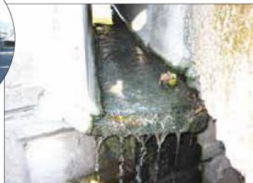
1970年代 単独処理浄化槽設置地域の側溝の例 (白っぽいへドロ状のものが堆積しています)
