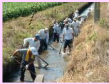
水路の泥上げ
