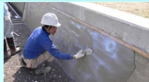
老朽化した水路壁のコーティング
