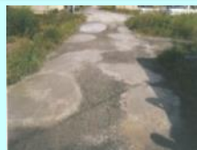
農道の窪みの補修
