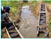
水田魚道の設置
