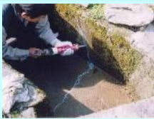
水路のひび割れ補修
