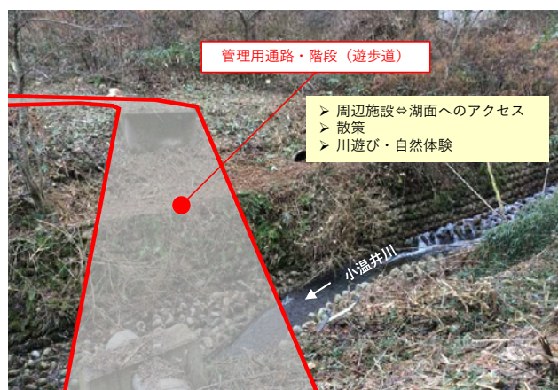
＜管理用通路・階段（遊歩道）＞
