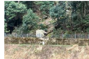
<ダム堤体下流左岸管理用通路> (現況)
