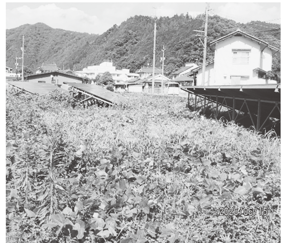
雑草が繁茂している状況
