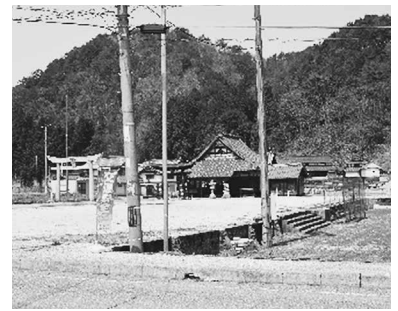
旧松原小学校跡地
