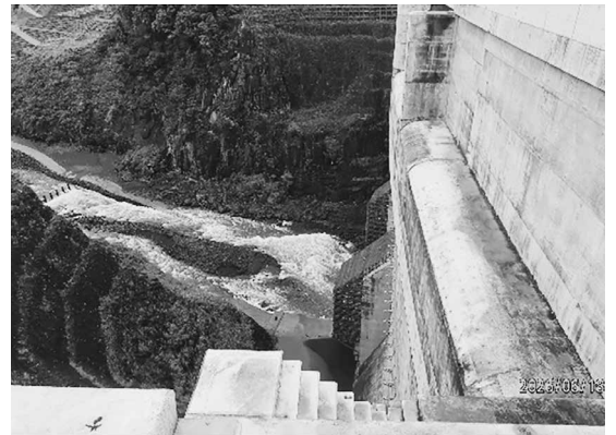
阿蘇立野ダム（上流側）
